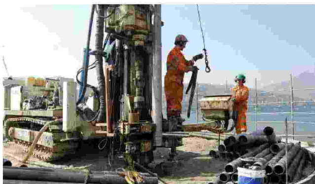
Sulla diga foranea è iniziata la posa dei micropali a sostegno del nuovo tondello
